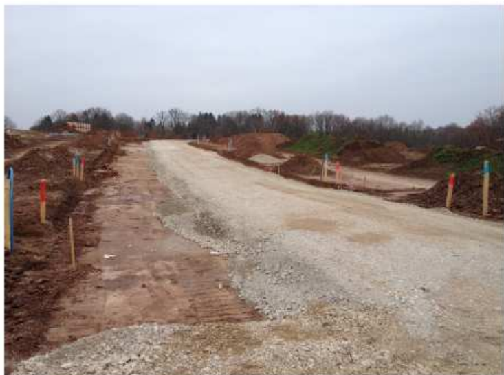
Der künftige Straßenverlauf ist schon gut erkennbar
