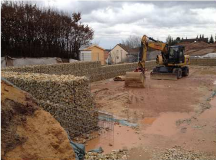
Das Regenüberlaufbecken oberhalb der bestehenden Bebauung
