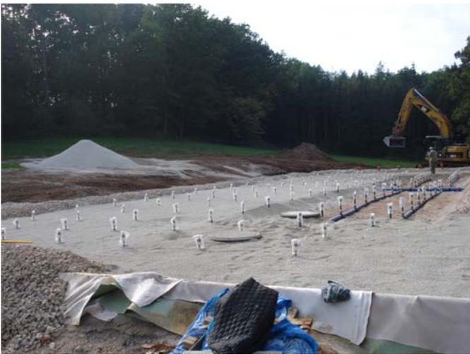
Während die Arbeiten am externen Filter schon fast vollendet sind, wurde im September mit den Arbeiten am Becken begonnen. Der alte Beckenkopf wurde abgetrennt und die Arbeiten für den neuen Beckenkopf mit oberliegender Wasserableitung wurden begonnen. Auch wurde die Verlegung der notwendigen neuen Leitungen gestartet.
