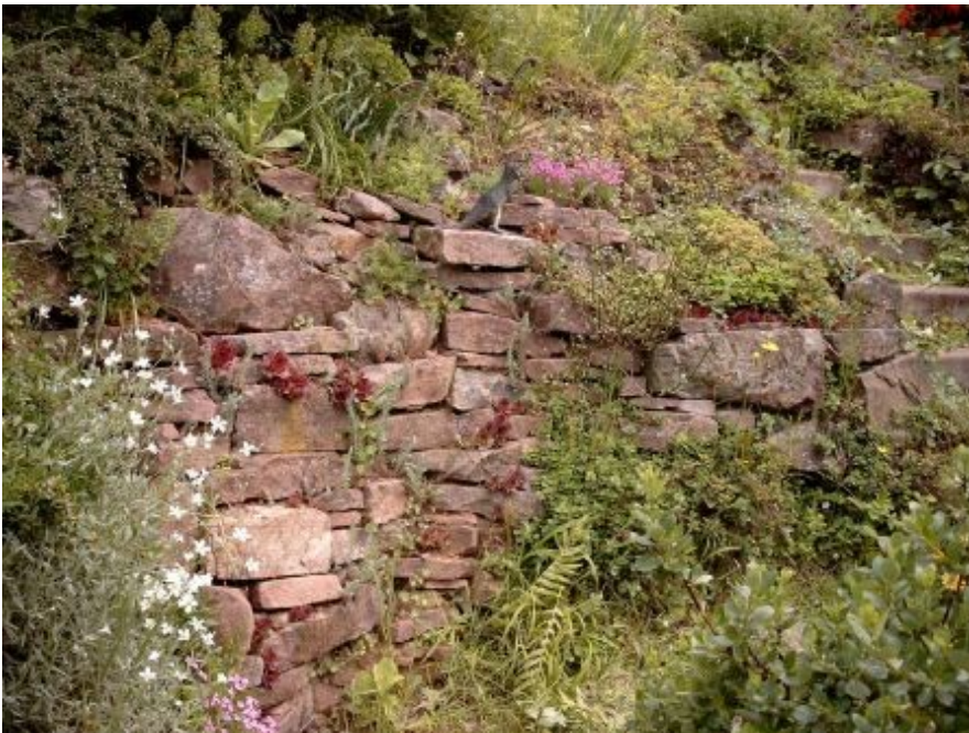
Beispiele für eine Hangmauer und eine freistehende Trockenmauer:
